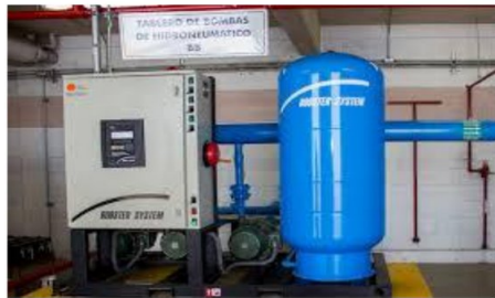
SISTEMA DE MANIPULACIÓN Y OPERACIÓN DE CUARTO DE BOMBAS
