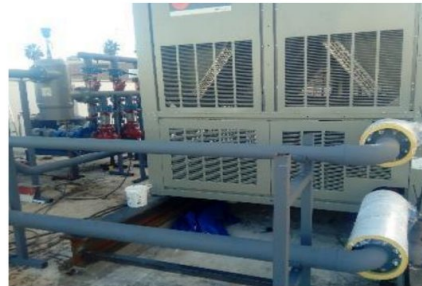
INSTALACIÓN DE CHILLER
